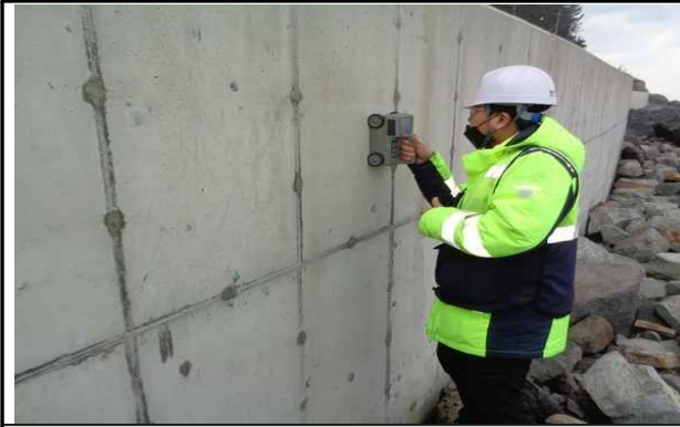
철근탐사시험 작업사진
