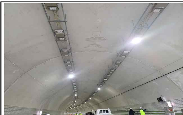
천단부 라이닝 전경
