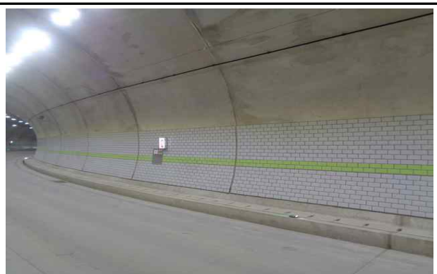
측벽부 타일 전경
