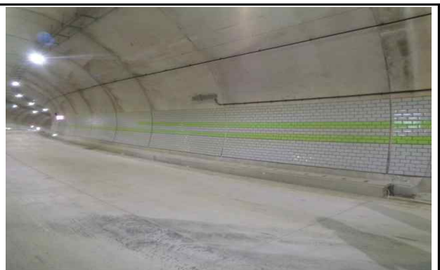
측벽부 타일 전경
