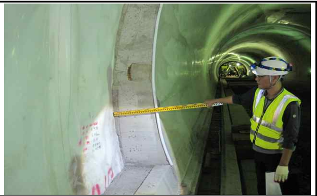
라이닝 콘크리트 현황
