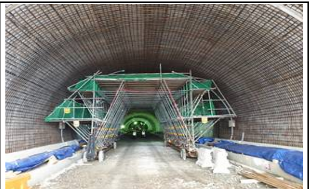
철근 작업 가시설 현황
