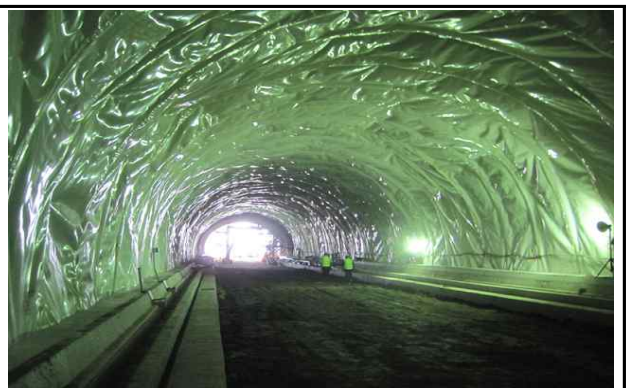
방수쉬트 시공 현황
