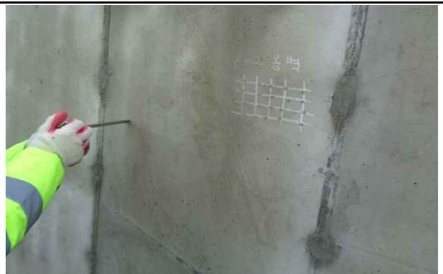
탄산화 진행깊이 시험
