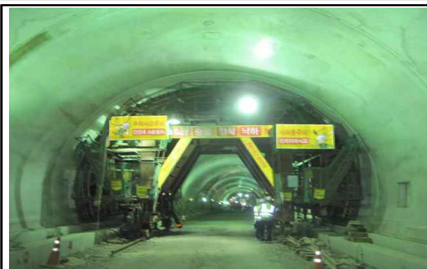
라이닝 콘크리트 타설 가시설 현황
