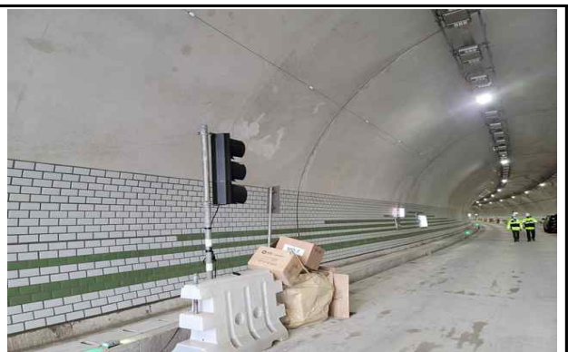
측벽부 타일 전경
