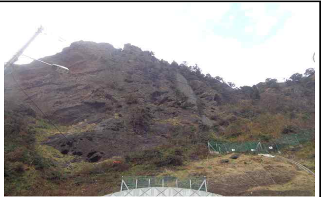
종점측 터널부사면 전경
