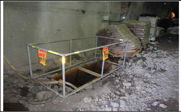
오·폐수 처리시설 전경
