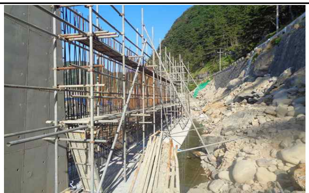
용벽 배면 강관 비계 설치 현황
