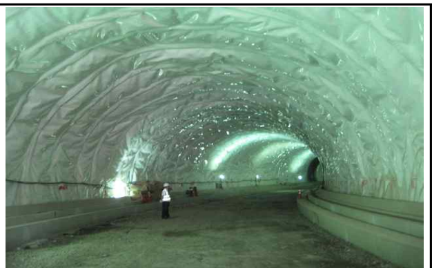
방수쉬트 시공 현황
