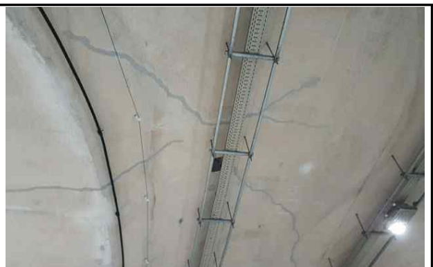
균열 보수 전경
