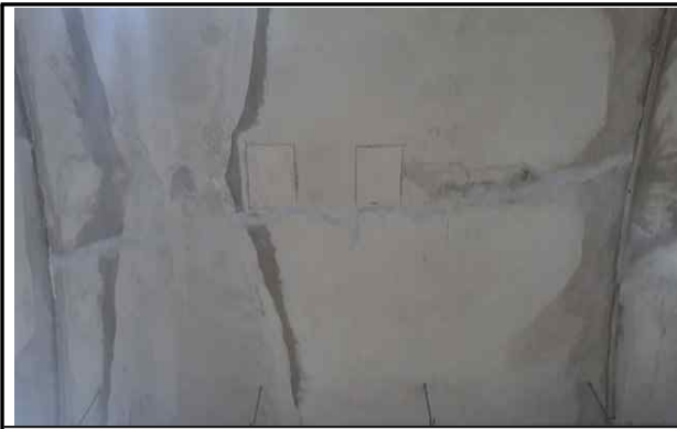
균열 보수 전경
