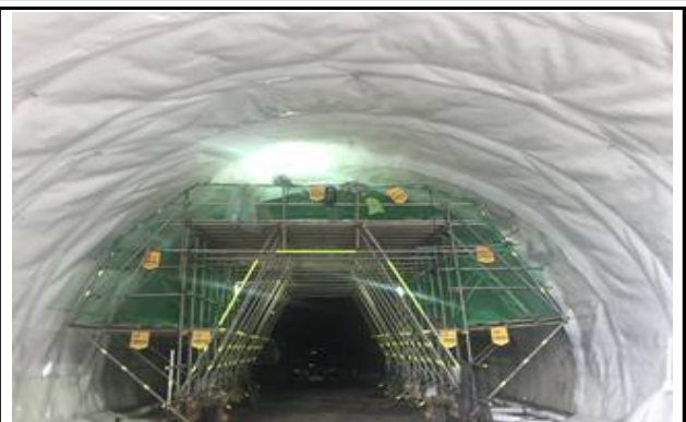
방수쉬트 작업 가시설 현황
