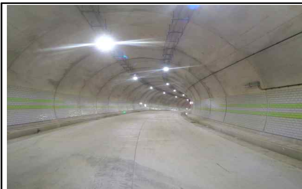
천단부 라이닝 전경
