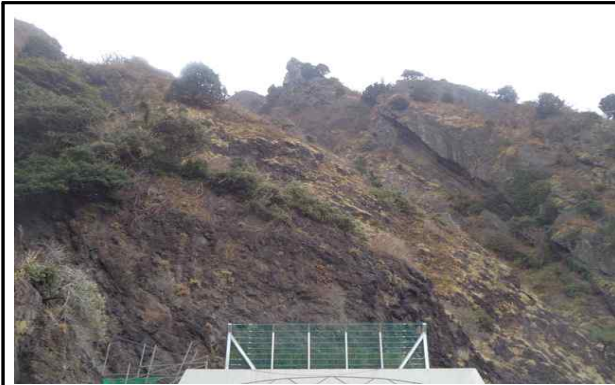
시점측 터널부사면 전경
