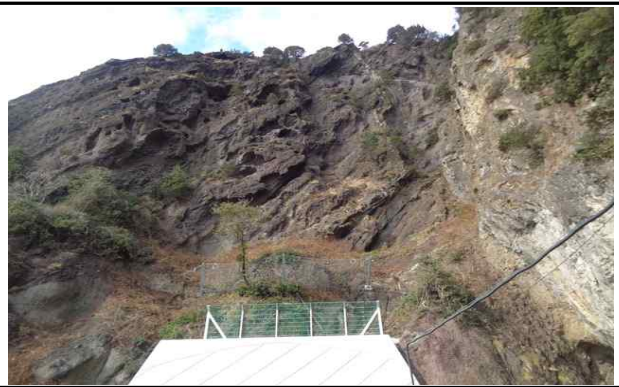
종점측 터널부사면 전경
