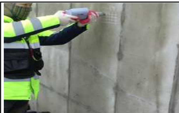
콘크리트 강도조사(반발경도시험) 전경
