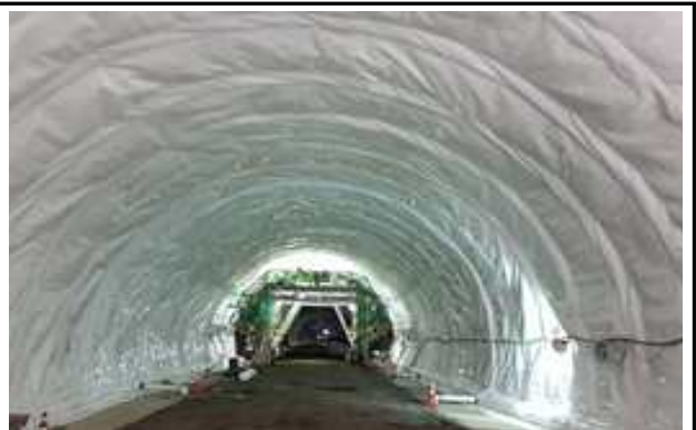
방수쉬트 시공 현황
