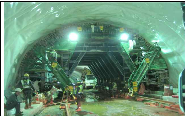
라이닝 콘크리트 타설 가시설 현황
