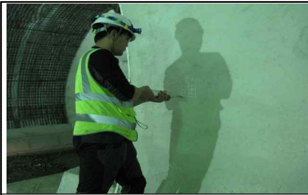
라이닝 콘크리트 강도 측정
