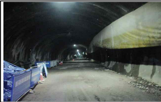
안전펜스 및 자재정리 현황
