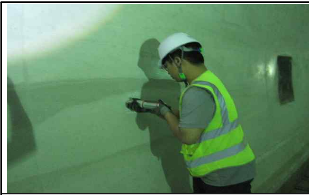
라이닝 콘크리트 강도 측정
