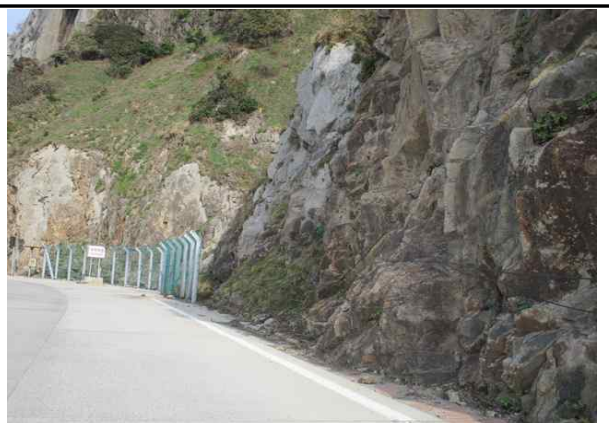
인접구간 낙석방지울타리 현황
