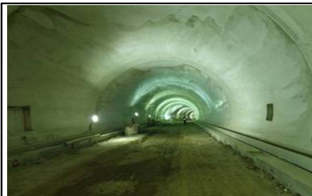
라이닝 콘크리트 현황
