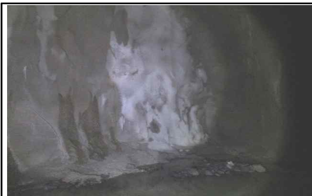
STA 2+850 터널 굴착 현황
