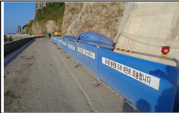
도로 안전 펜스 전경
