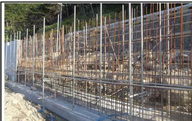
용벽 전면 강관 비계 설치 현황
