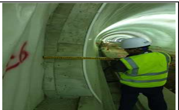
라이닝 콘크리트 현황
